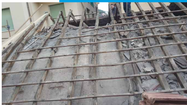
La demolizione del vecchio tetto
