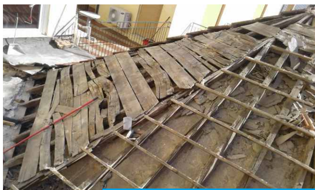
La demolizione del vecchio tetto
